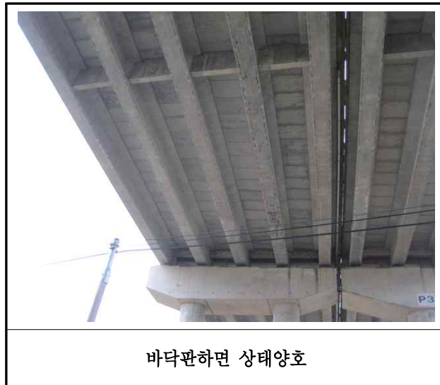
【사진 14.3.26】 바닥판하면 손상현황
