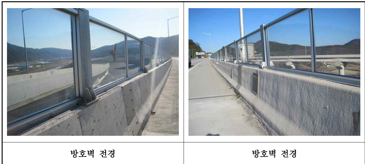
【사진 14.3.23】 방호벽 및 중앙분리대 전경
