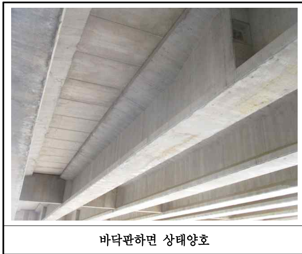
【사진 14.3.3】 바닥판하면 손상현황
