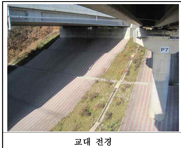
【사진 14.3.8】 교대 전경
