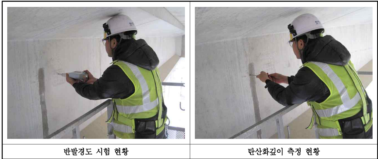
【사진 14.4.1】 콘크리트 내구성조사 현황
