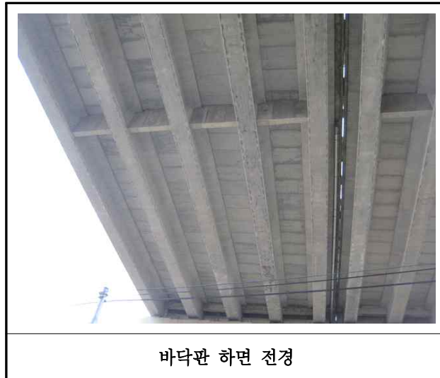
【사진 14.3.25】 바닥판하면 전경
