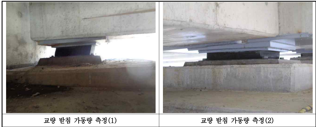
【사진 14.3.15】 교량받침 이동량 측정
