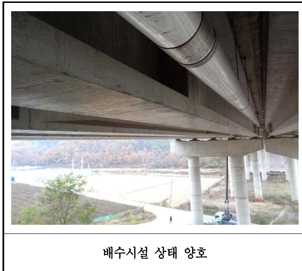
【사진 14.3.45】 배수시설 손상현황
