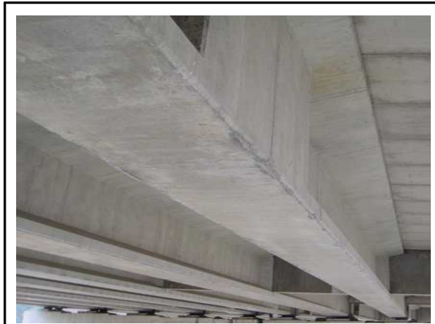
거더 내측 전경
