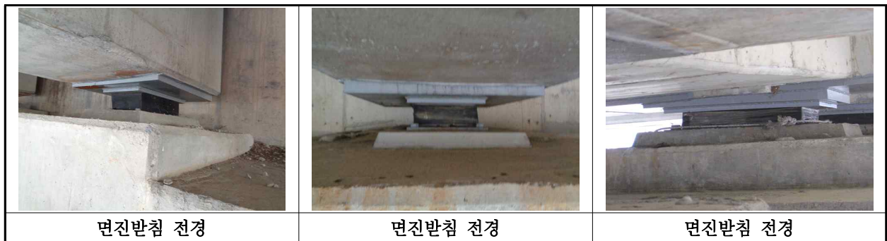
【사진 14.3.12】 교량받침 전경
