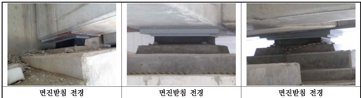
【사진 14.3.35】 교량받침 전경
