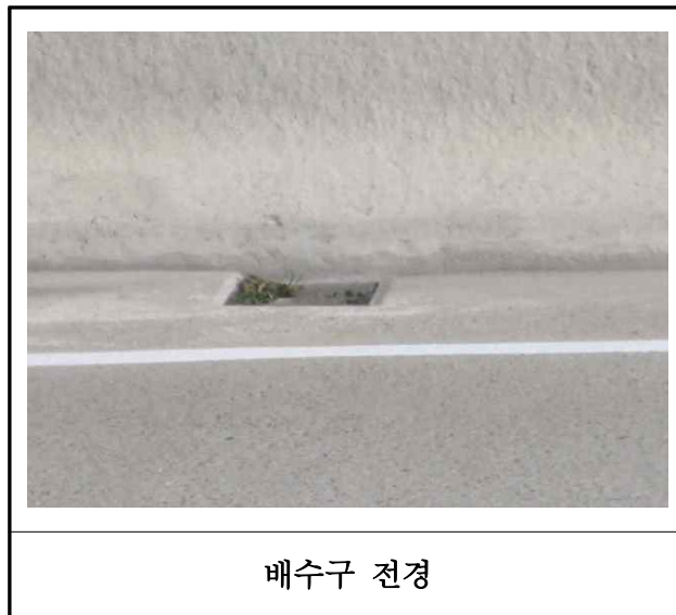
【사진 14.3.44】 배수시설 전경
