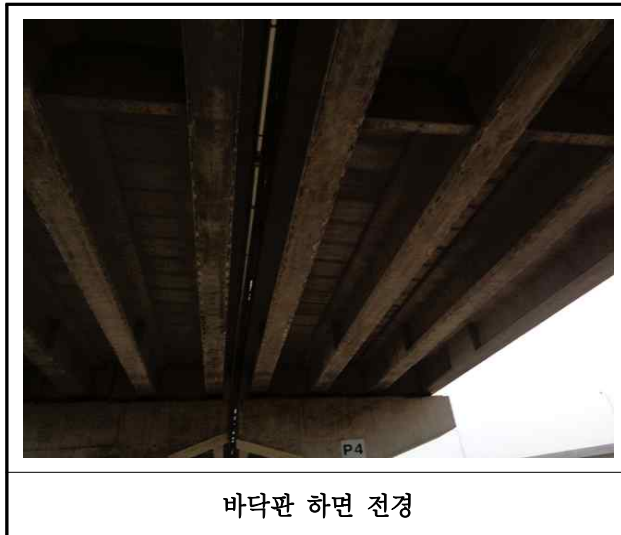
【사진 14.3.2】바닥판하면 전경
