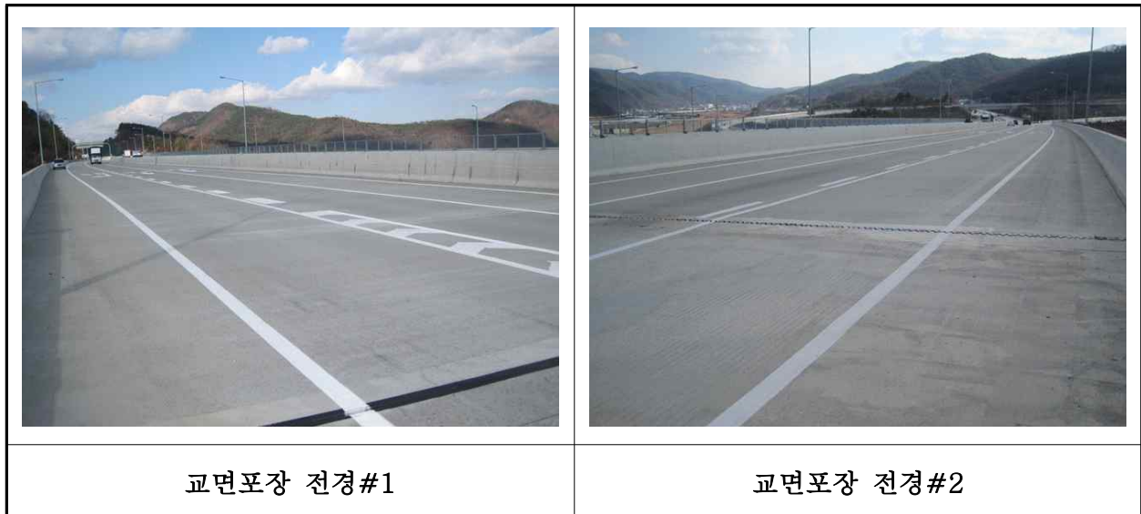
【사진 14.3.42】 교면포장 전경
