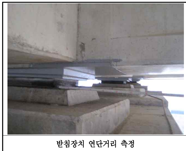
【사진 14.3.37】 교량받침장치 연단거리측정
