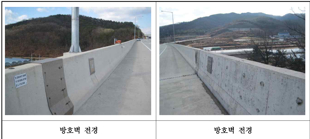
【사진 14.3.46】 방호벽 및 중앙분리대 전경
